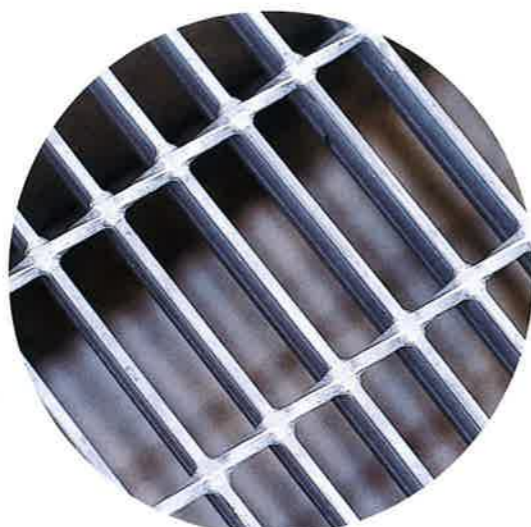
WATER JET 洗浄後
